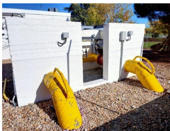
Figura 8. Líneas de regulación en las ERM. Fuente: CBCM
