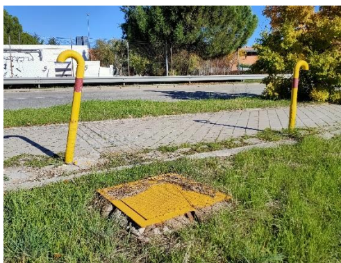
Figura 4. Poste de señalización de tubería y arqueta. Fuente: CBCM
