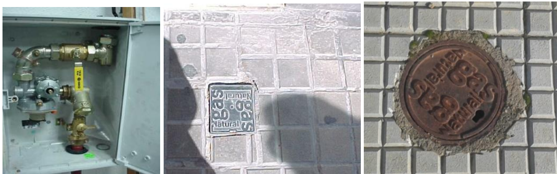
Figura 11. Llave de acometida. De izquierda a derecha: en armario de regulación, en arqueta de polipropileno y en arqueta de fundición. Fuente: CBCM
