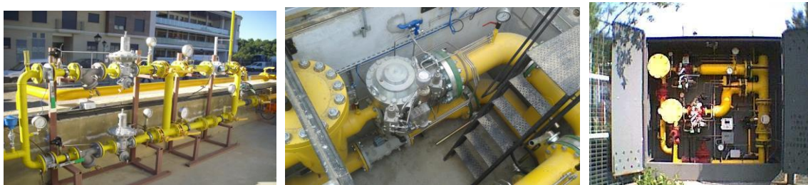
Figura 7. ERM. De izquierda a derecha: al aire libre, soterrada, en armario aéreo. Fuente: CBCM
