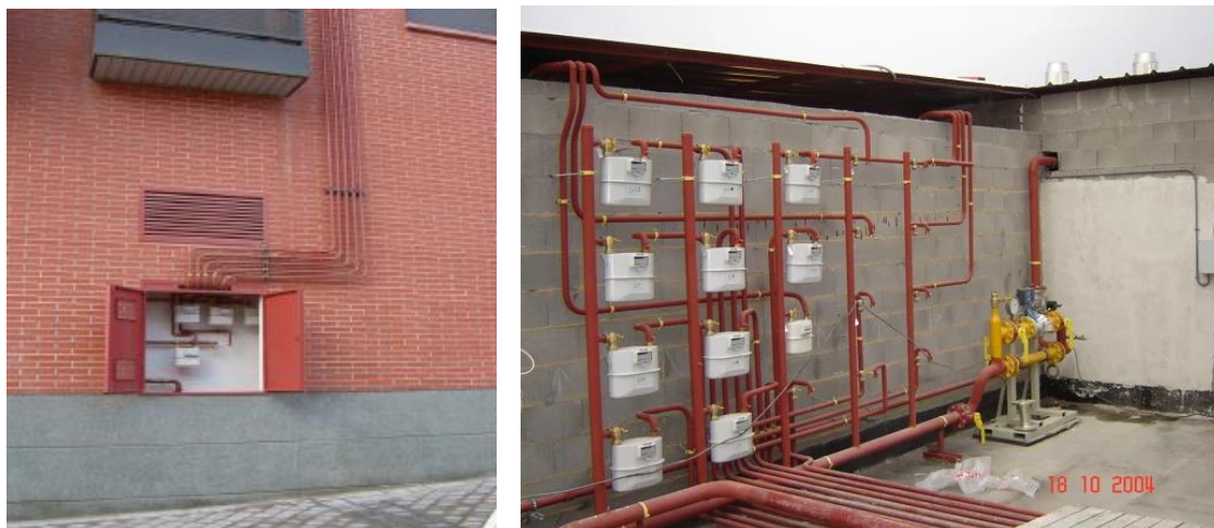
Figura 13. Armario de regulación. A la izquierda en fachada, y a la derecha en azotea. Fuente: CBCM
