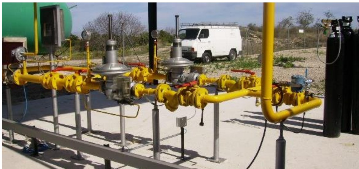
Figura 24. Equipo de regulación. Fuente: CBCM
